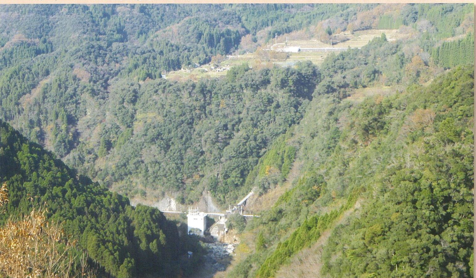
日之影発電所遠景。発電は、山の上の用水路から谷底に落ちてゆく水の力で行われる（写真提供：水土里ネット日之影）
