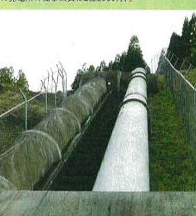
路式の発電である。水圧鉄管(右)と余水管(左)。
