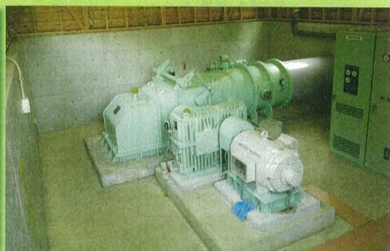
クロスフォー水車が中に入っている。最大出力190kw。水力発電は、太陽光に比べると、16
