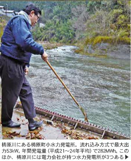
榜原川にある榜原町小水力発電所。流れ込み方式で最大出力53kW。年間発電量(平成21~24年平均)で282MWh。このほか、榜原川には電力会社が持つ水力発電所が3つある▶上写真は、取水口のゴミを取り除く役場担当の那須さん
