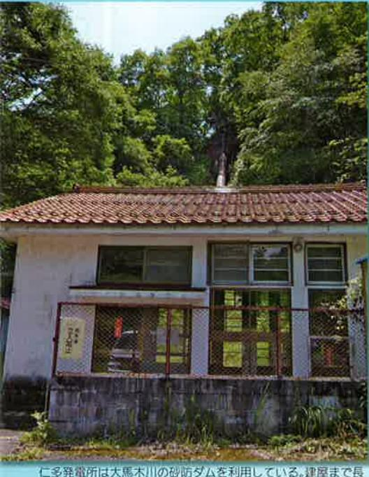
仁多発電所は大馬木川の砂防ダムを利用していている。建屋まで長さ43.7mの水圧鉄管が伸びている。取水量は1.00m<sup>3</sup>/秒。最大出力185kWh。現在売電価格8円55銭(税込)/kWh
