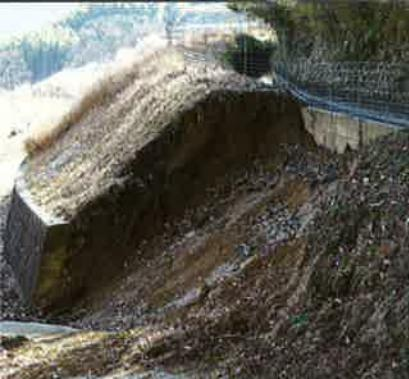
地震と豪雨で水路が崩れた。コンクリートは昭和40年代に素掘りの土水路から変えたときのまま(峰)
