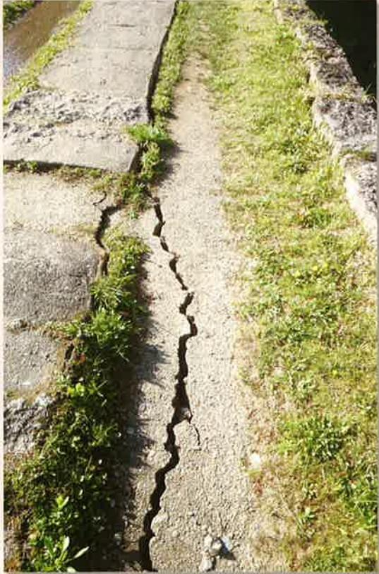
通潤橋の上の被覆土に生じた亀裂。現在も立ち入り禁止が続く
