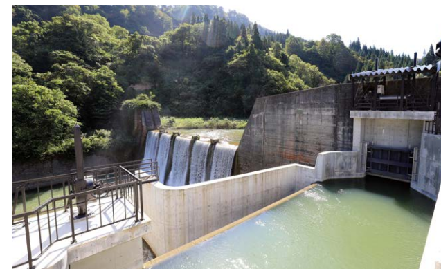
小水力発電施設 (おおくら升玉水力発電所)
